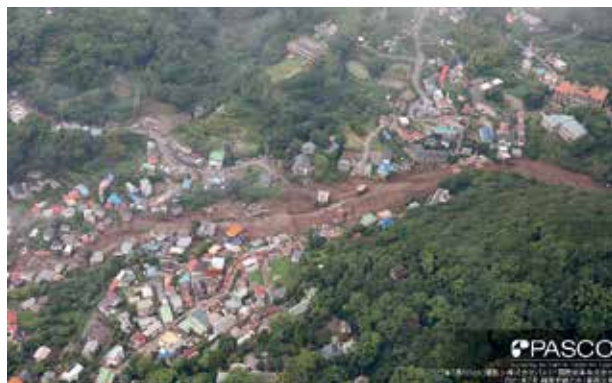
令和3年7月 静岡県熱海市伊豆山土石流の様子
